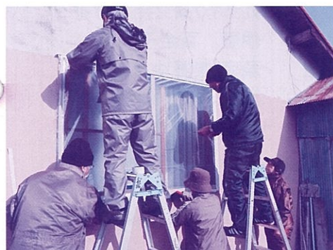
ボランティアセンター (独居宅ビニール張りの様子)
