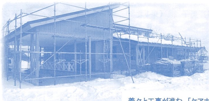
着々と工事が進む「ケアホーム春風」
