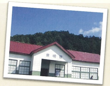
写真：美唄鉄道旧東明駅舎（9月撮影）
